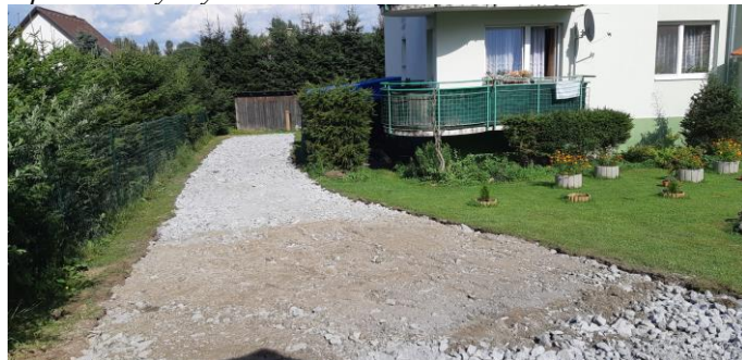
Prístupová komunikácia k ČOV
