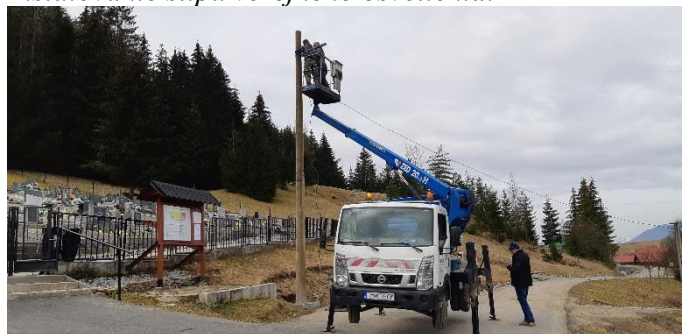
Inštalovanie stĺpu verejného osvetlenia.
