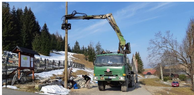
Inštalovanie stĺpu verejného osvetlenia.
